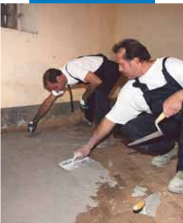
Nanášení první vrstvy malty Planitop HDM Restauro hladítkem na rubovou stranu klenby
