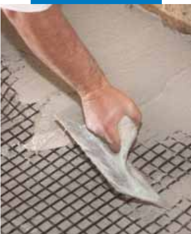
Nanášení druhé vrstvy malty Planitop HDM Restauro hladítkem na rubovou stranu klenby tak, aby byla síť Mapegrid G 220 pokryta stejnoměrnou vrstvou malty
