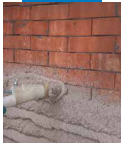
Aplikace Planitopu HDM Restauro na stěnu z cihelného zdiva
