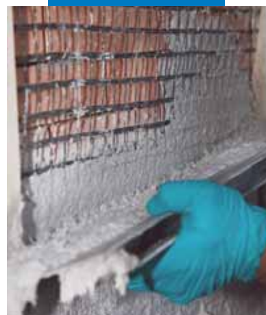
Aplikace Planitopu HDM Restauro a Mapegridu G 220 na stěnu z cihelného zdiva
