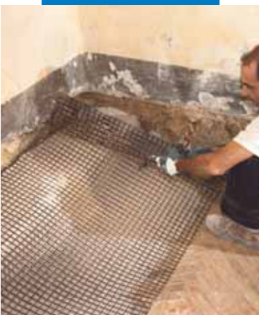
Osazení vyztužující sítě ze skelných vláken Mapegrid G 220 (odolné proti alkalickým vlivům)
